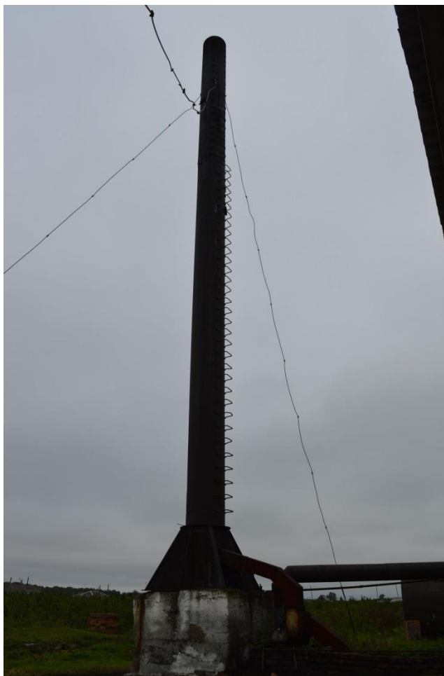
Рисунок 1.7 – Дымовая труба котельной с. Усть-Изес
