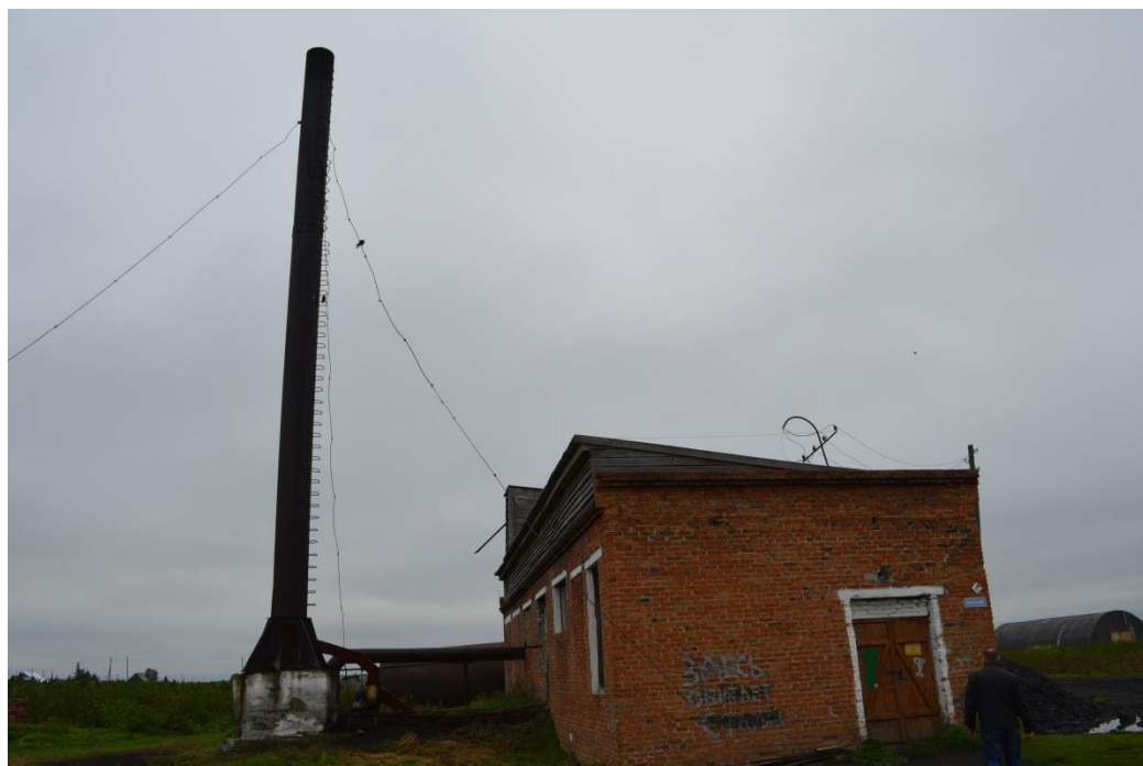
Рисунок 1.2 – Котельная с. Усть-Изес
